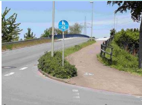
Gemeinsamer Geh-/Radweg (Franz-Kleine-Straße)
