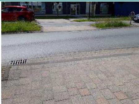
Kreisverkehrsplatz Paderborner Straße
