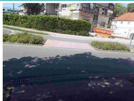
Kreisverkehrsplatz Geseker Straße (innerorts)
